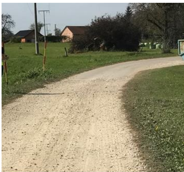
Slika 2: pričetek obdelave, navezava na asfaltirano cesto
